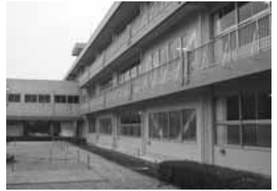
耐震工事後教室棟
